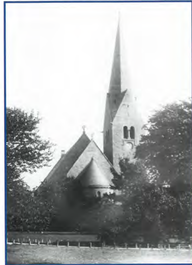
Et flott bilde av Vålerengens vakre kirke, lenge før taket forsvant...
